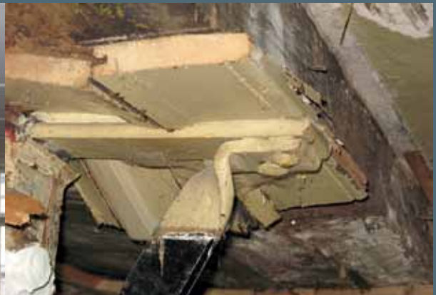
▼ Læg mærke til hvordan bjælken, som er lagt af på en knægt, har mast et forskallingsbræt. Det viser hvilken vægt bjælken bærer.
