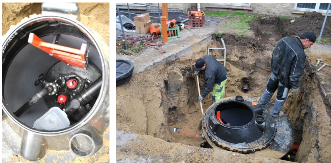
Figur 8.6. Eksempel på et præfabrikeret lukket anlæg placeret i en brønd uden for bygning.
