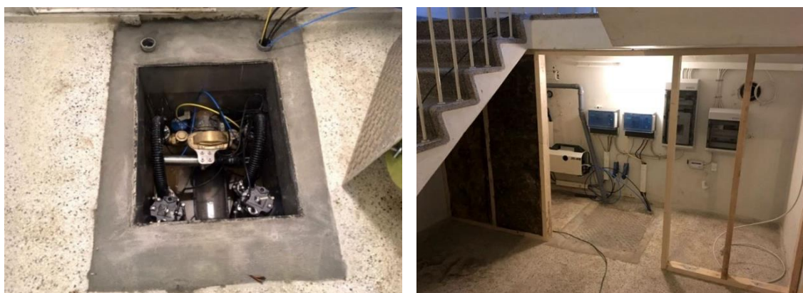
Figur 8.5. Eksempel på et kompakt lukket anlæg placeret i kældergulv.
