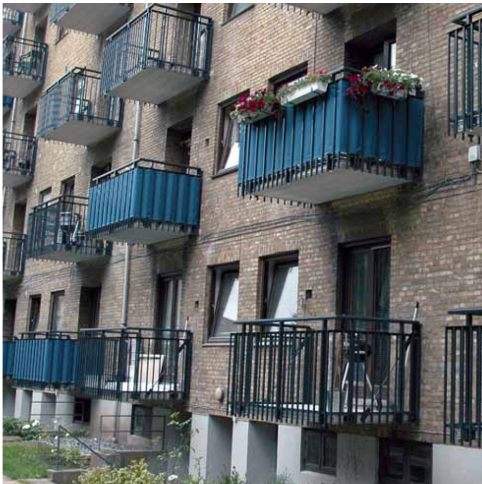
Eksempel på ens altaner i lodrette kolonner ( København ).
