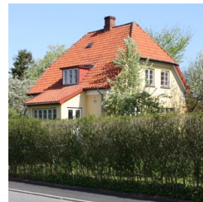
Bevaringsværdig Bedre Byggeskik-villa, hvor de oprindelige vinduer er bevaret. Bevaringsværdien gælder kun for det ydre.
