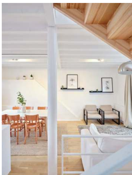
I den øverste bolig er trækonstruktionen i det nye etagedæk synlig. ←
