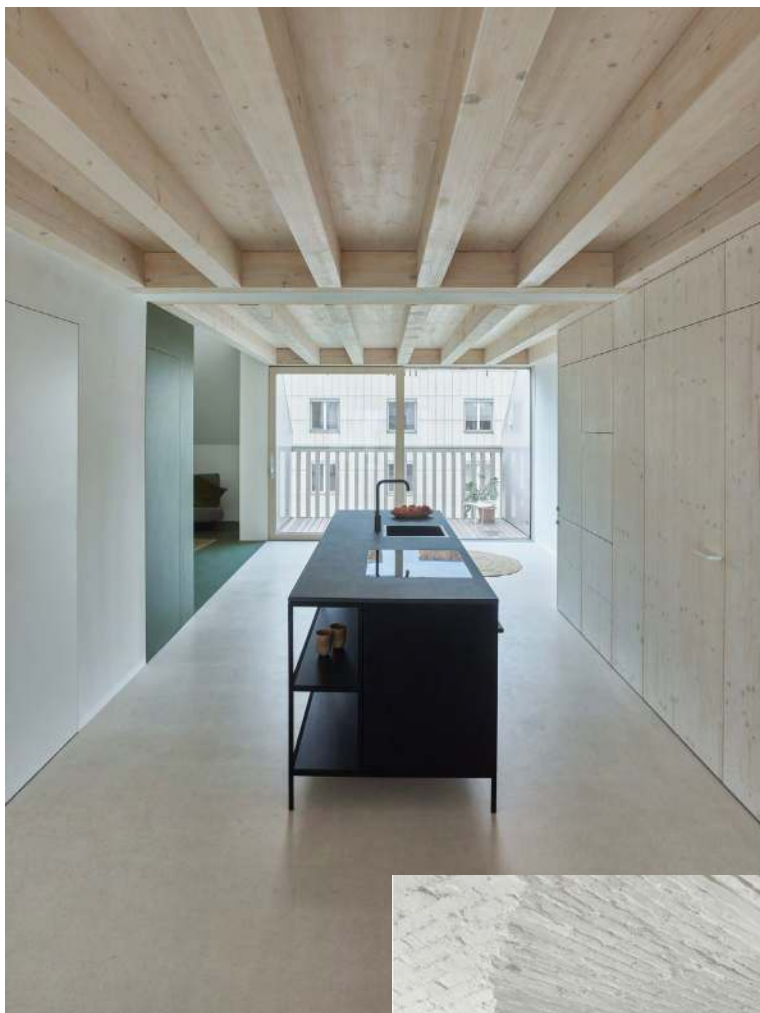
De øverste etager er bygget som en trækonstruktion, hvilket tydeligt ses i boligernes lofter. ←
