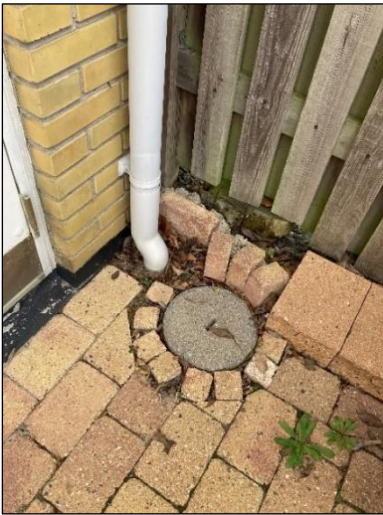
Figur 2.11. Tagnedløb med tæt tilslutning til nedløbsbrønden.
