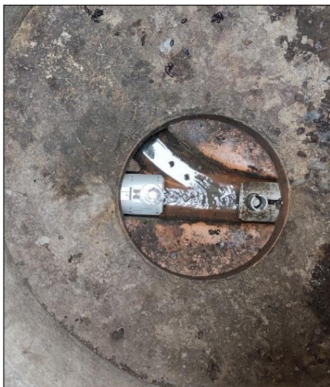
Figur 1.1. Nogle går både med livrem og seler. Her er der rottespærre både i indløb og i udløb af brønden.
