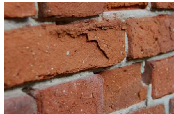
Figur 26 Nogle gange afslører murværket, at der er højt saltindhold i murværksmaterialerne, andre gange er det ikke synligt.
