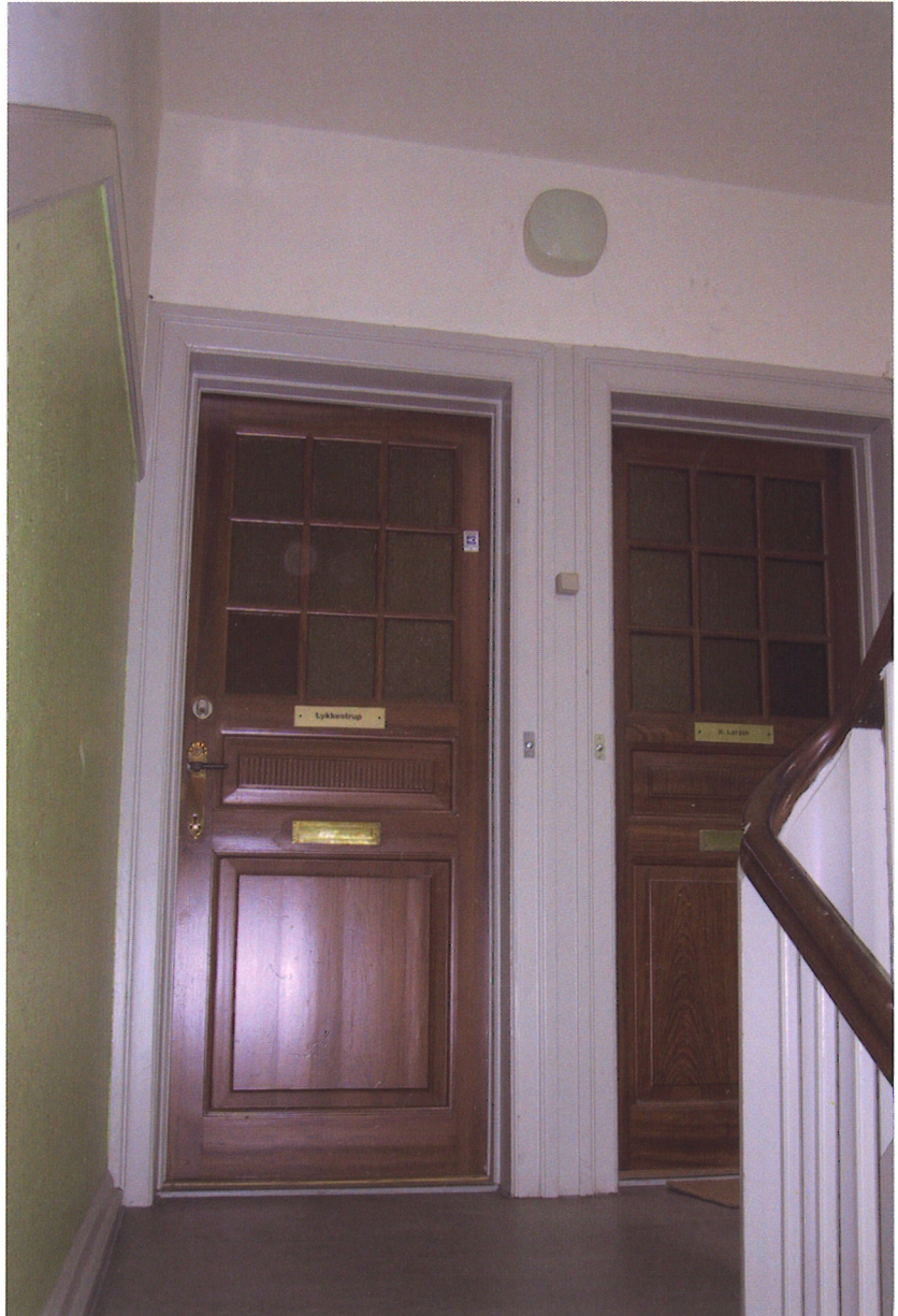
Den færdige trappe med sprinkleren monteret over lampen mellem entrédørene. Sprinkleren er så lille, at den knap er synlig.
