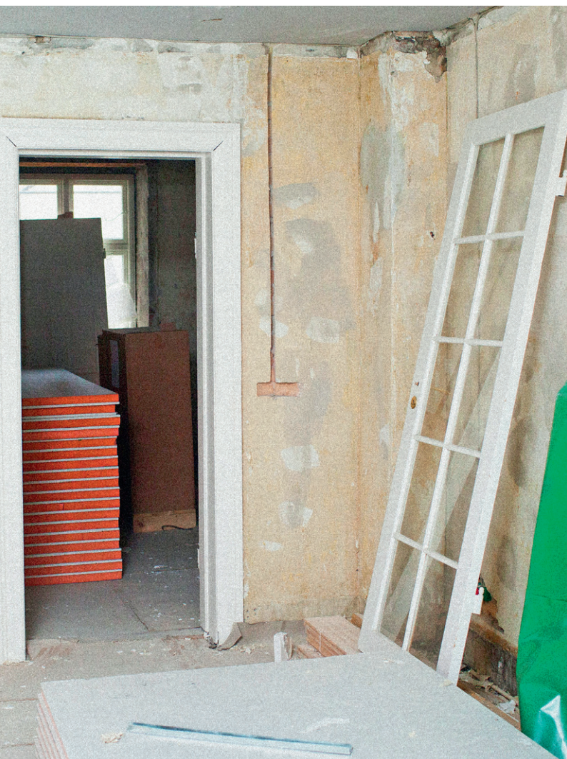
↑ Her er isoleringspladerne med gips og plastsium klar til montering ved renoveringsprojektet i Ryesgade.
